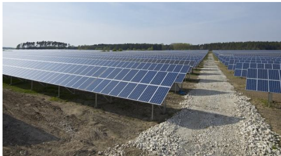
Abbildung 13 Typische Freifield-Installation, 2-reihig, portrait-Orientierung
